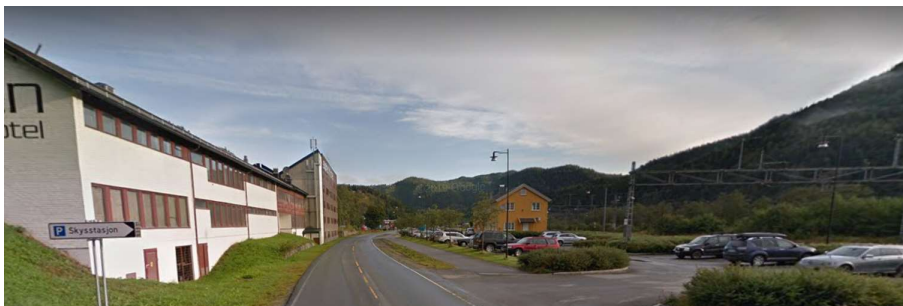
Figur 32: Støren stasjon sett fra sør (Google streetview).
